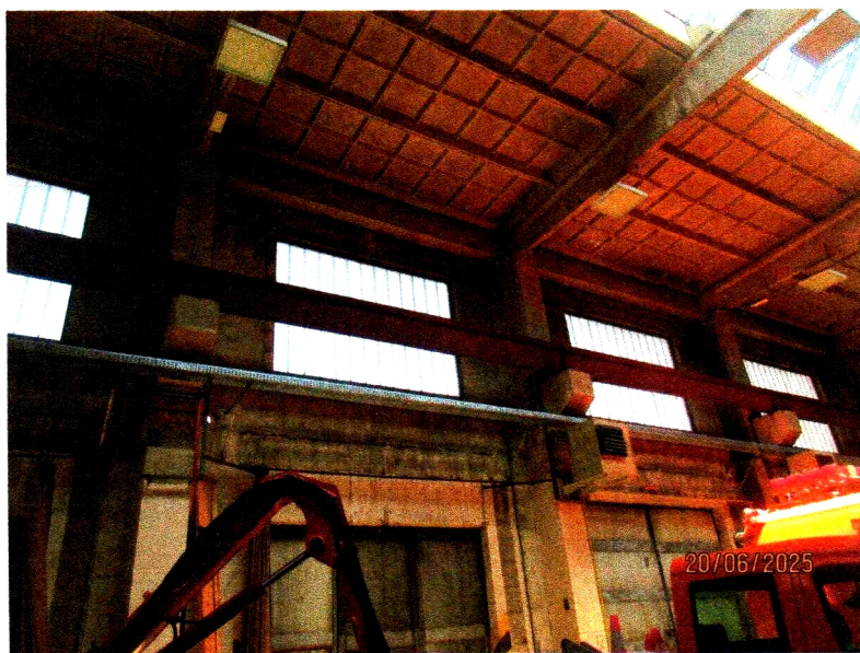
Foto č.2 Nosnou konstrukci haly tvoří železobetonový skelet , který má plášť proveden z keramických panelů.
