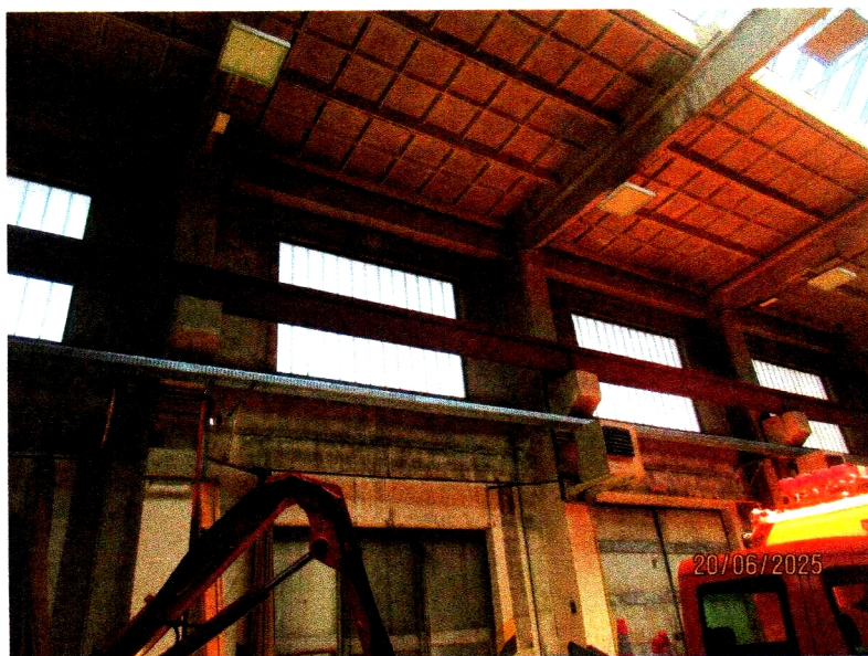
Foto č.5 U vyšších vrat je překlád rovněž tvořen keramickým panelem. Spodní část byla odříznuta, odbourána. Mělo by to jít i u ostatních vrat. Soudržnost keramických panelů opláštění je veliká. Odříznuté nadpraží se začistí zednickým způsobem - omítnutím.
